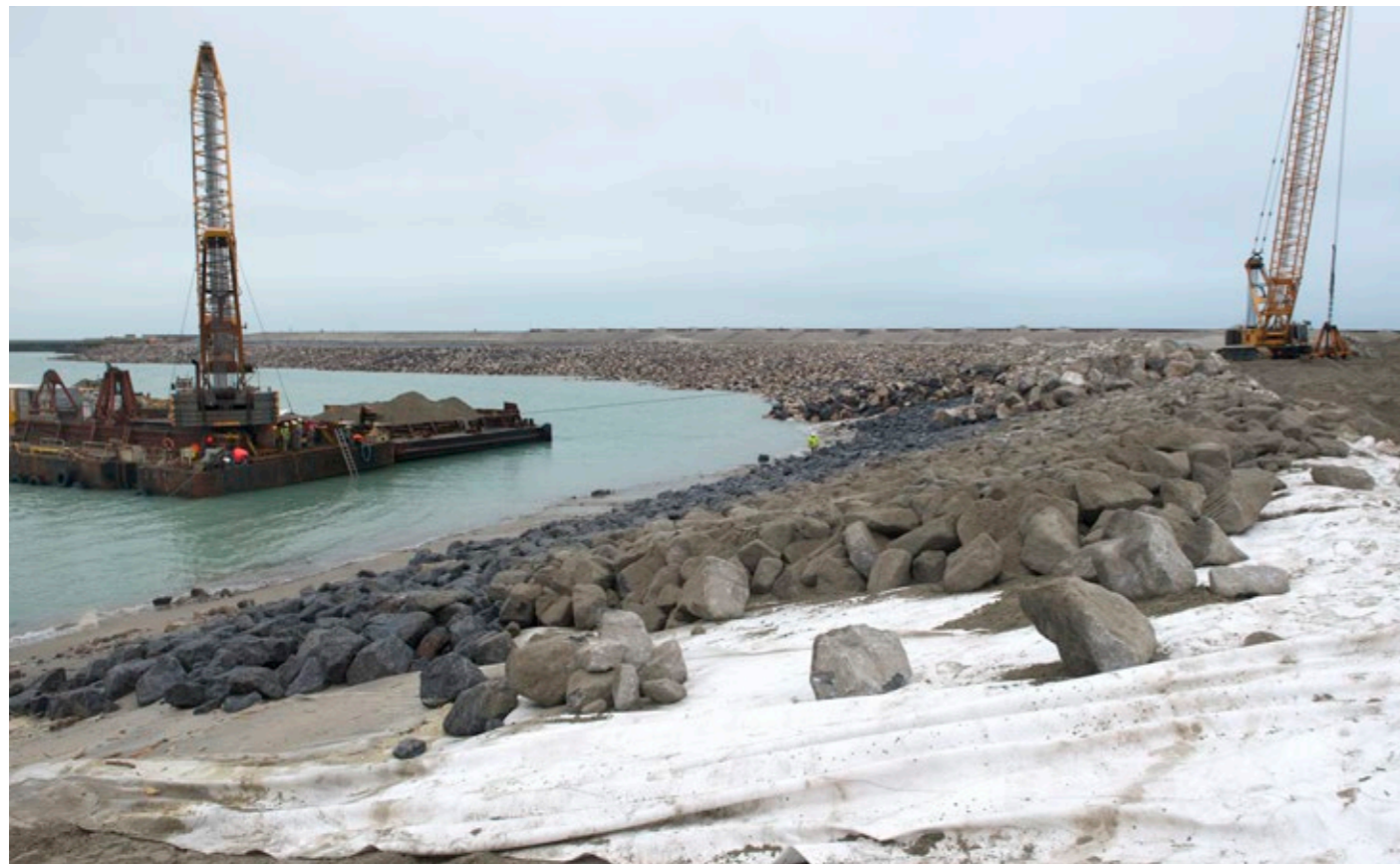
Bontec Protec Les enrochements traditionnels sont constitués de granulés fins à grossiers qui forment un filtre naturel. L'utilisation de géotextiles peut remplacer jusqu'à 1 m de ce filtre naturel, tout en évitant un éventuel lessivage du sable.
