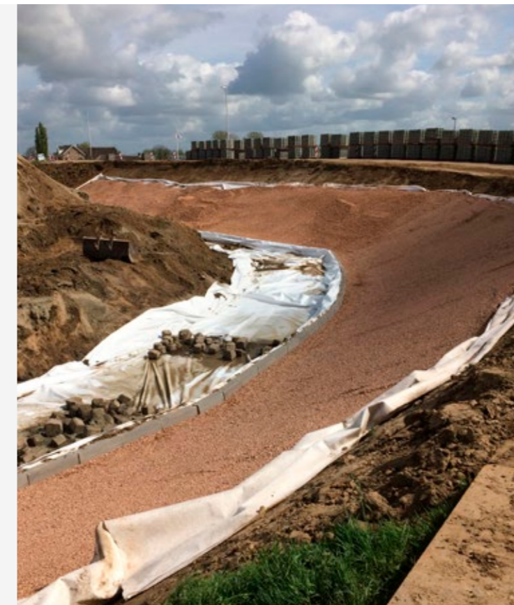
Bontec NW Les géotextiles utilisés dans la construction des digues empêchent le mouvement des particules du sol (renard hydraulique). Le renard est le phénomène de transport de particules du sol par infiltration d'eau, créant des ouvertures tubulaires sous la digue.
