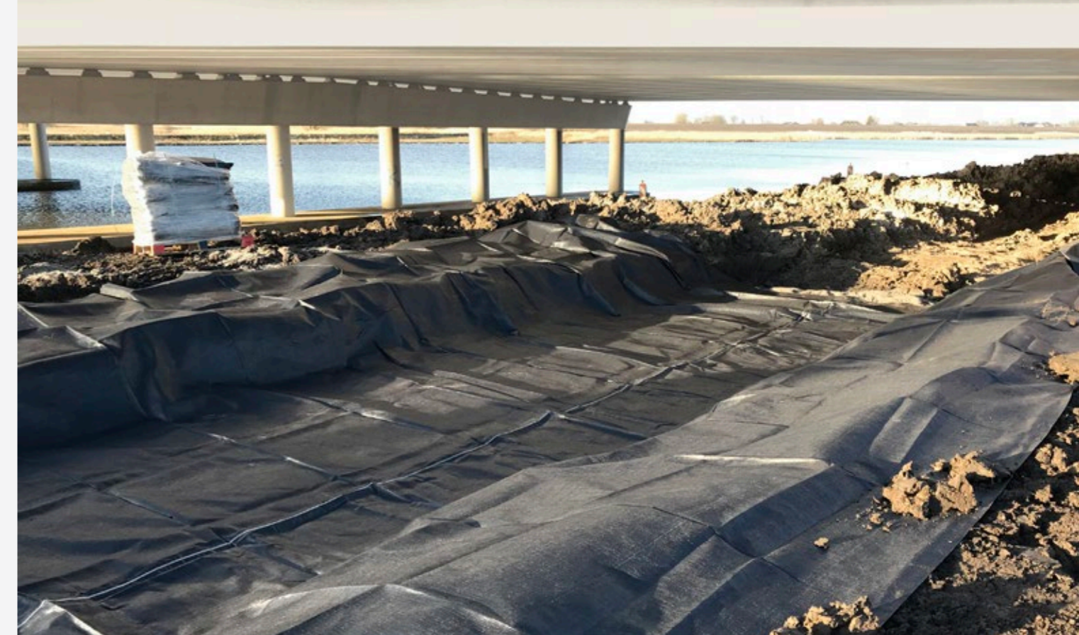
Bontec SG Dans les fondations de nouvelles constructions routières, des géotextiles sont utilisés pour la séparation et la filtration afin d'éviter le mélange des matériaux granulaires. La durée de vie des routes s'en trouve prolongée.
