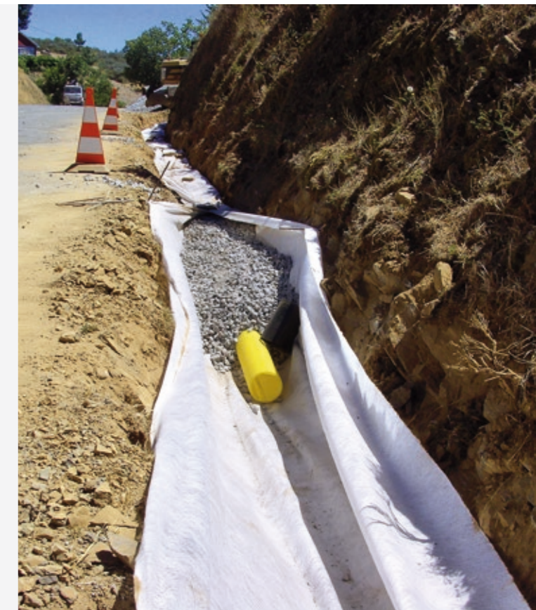
Bontec NW Enveloppé autour des « drains français » (en pierres sèches), le géotextile Bontec agira comme une couche filtrante, réduisant le besoin de matériau granulaire et empêchant les remblais de se colmater.
