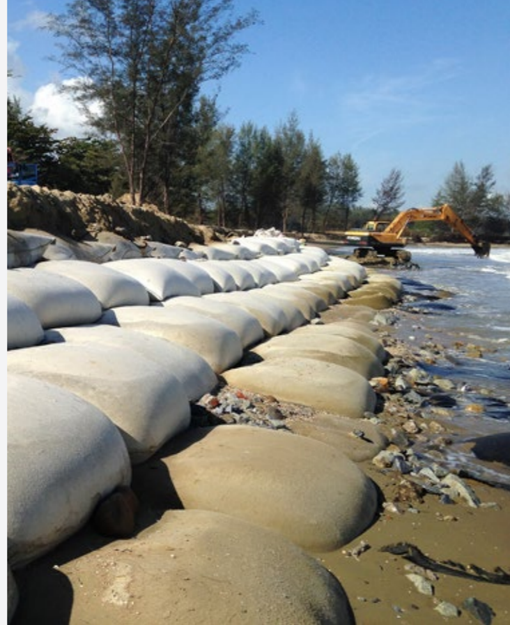
Bontec SNW De nombreuses plages de sable du monde entier sont soumises à une érosion continue. Des géosacs remplis localement peuvent protéger ces plages et les infrastructures avoisinantes.
