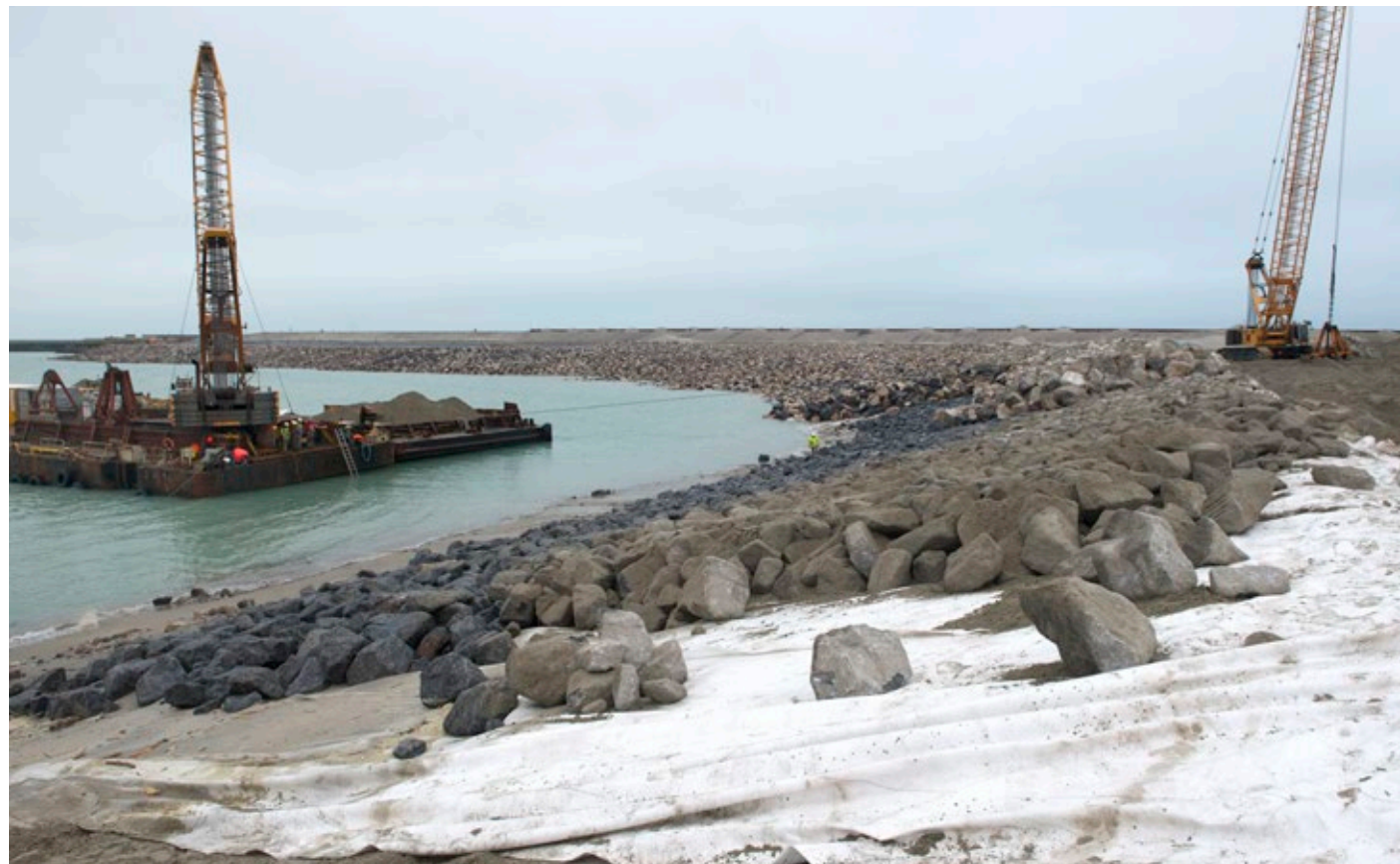
Bontec Protec Traditionele 'rock revetments' zijn opgebouwd uit lagen van fijne tot grove granulaten om een natuurlijke filter te vormen. Het gebruik van geotextiel kan tot 1 m van zo'n natuurlijke filter vervangen terwijl het tegelijkertijd het eventuele wegspoelen van zand voorkomt.
