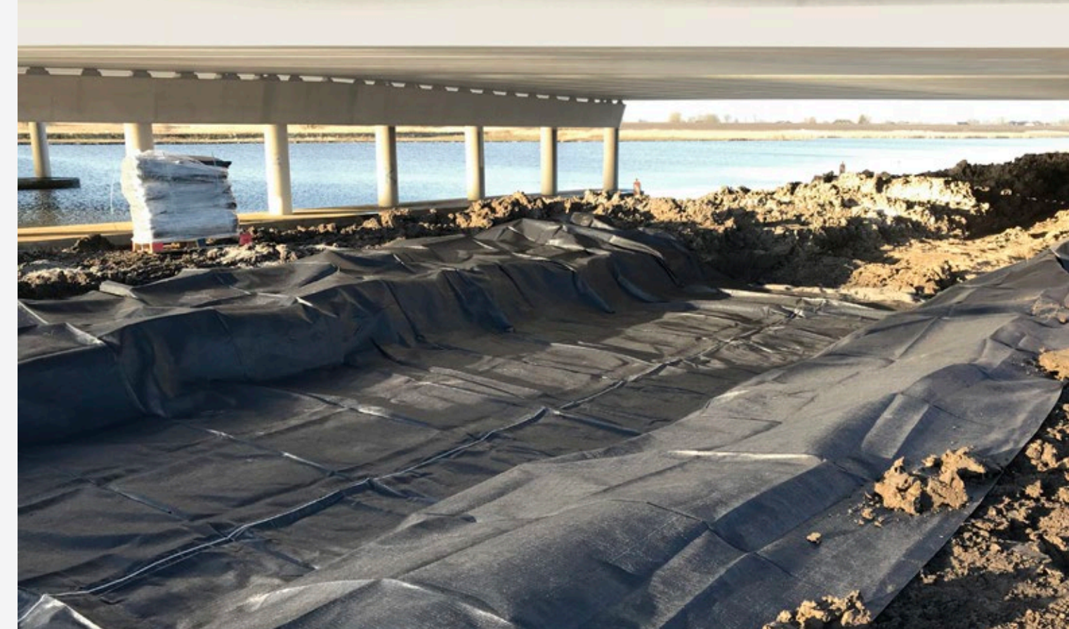
Bontec SG In de fundering van nieuwe wegconstructies worden geotextielen veelal gebruikt voor separatie en filtratie, om het vermengen van granulaire materialen te vermijden. Op die manier wordt de levensduur van de wegen verhoogd.
