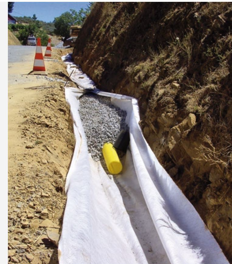
Bontec NW Wanneer geotextiel rond 'French Drains' wordt gewikkeld zal dit zich gedragen als een filterlaag. Hierdoor is minder granulair materiaal nodig en wordt vermeden dat de drain verzandt.
