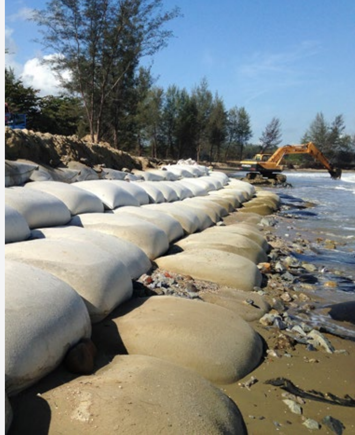
Bontec SNW Vele zandstranden overal ter wereld zijn onderworpen aan erosie. Lokaal gevulde geobags kunnen deze stranden en de nabij gelegen infrastructuur beschermen.
